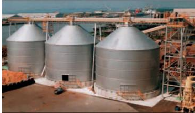
Рис.1. Бункерные сооружения на заводе по выпуску МДФ
